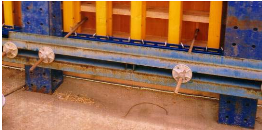
Abb. 3: Abdichtung der Aufstandsfläche einer Wandschalung
