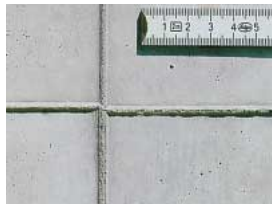
Kunst der Fuge: Spezielle „Sichtbetonschalungen“ gibt es nicht, alle Schalverfahren eignen sich dafür, abhängig von den Ansprüchen. Die Ausbildung der unvermeidlichen Fugen kann dabei zum gestaltenden Element werden.
