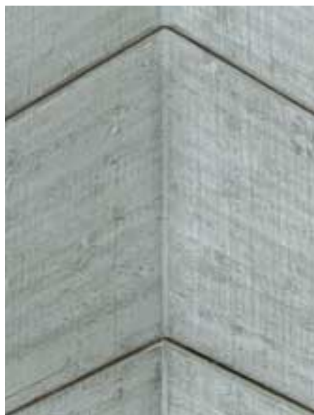
Kunst der Fuge: Spezielle „Sichtbetonschalungen“ gibt es nicht, alle Schalverfahren eignen sich dafür, abhängig von den Ansprüchen. Die Ausbildung der unvermeidlichen Fugen kann dabei zum gestaltenden Element werden.
