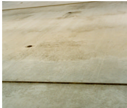
Abb. 4: Überdosierung des Trennmittels auf einem Wandschalungselement (links), Konsequenzen an der Betonfläche infolge einer Betontrennmittelüberdosierung (rechts)
