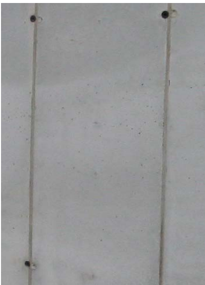
Bild 2: Gute Betonflächenqualität mit SVB: a) Eigene Aufnahme b) Aus [9]
