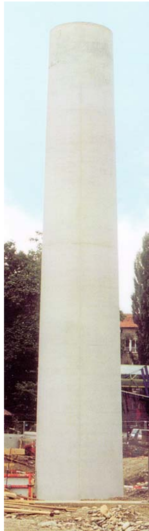
Bild 2: Gute Betonflächenqualität mit SVB: a) Eigene Aufnahme b) Aus [9]
