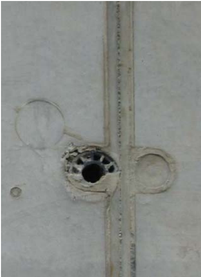
Bild 1: Exakter Abdruck der Schalungshaut mit Ausbesserungsstelle
